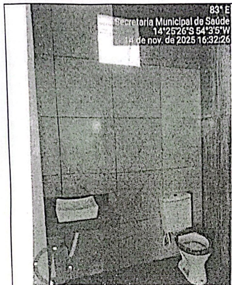
Figura 17 Vista interna banheiro masculino piso térreo
