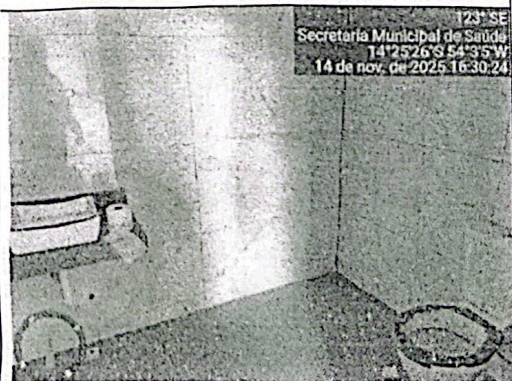
Figura 16 Vista interna banheiro feminino piso térreo
