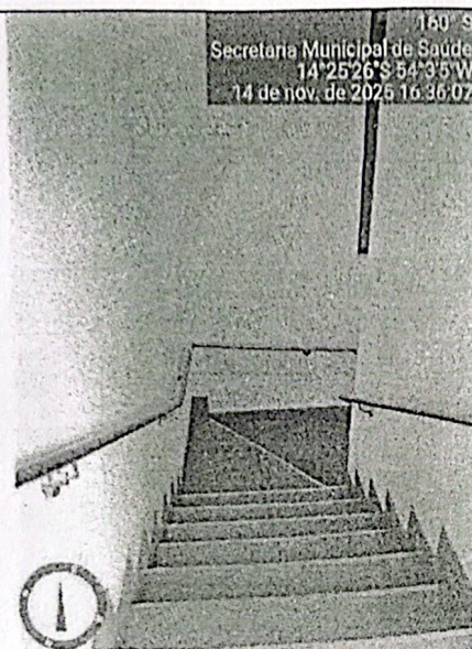
Figura 29 Escadas para acesso ao piso superior com corrimão de inox acoplado na parede
