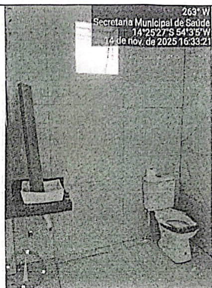
Figura 22 Vista interna banheiro feminino piso térreo
