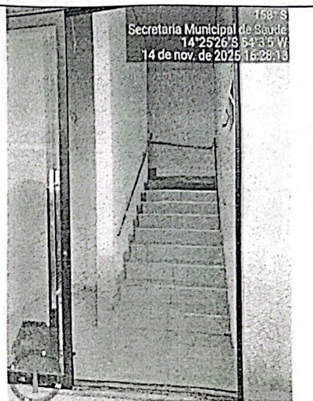
Figura 6 Escada que dá acesso ao piso superior
