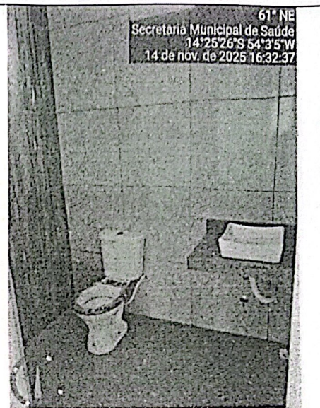
Figura 18 Vista interna banheiro feminino piso térreo
